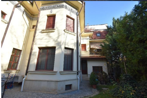
Vedere Subsol 2 C1:
