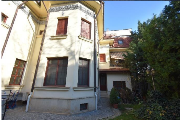
Vedere Subsol 2 C1:
