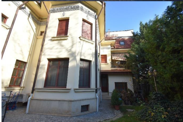
Vedere Subsol 2 C1:
